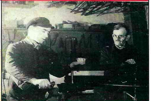
Franz Rosenkranz in der Klempnerwerkstatt
