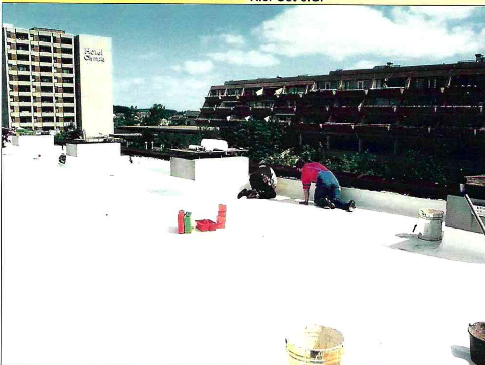
Olympiagebäude in Kiel-Schilksee
